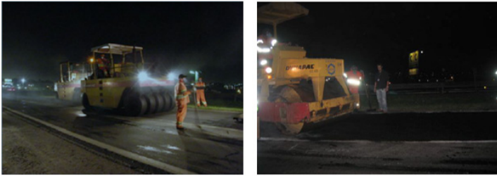
Figura 10 Fotos da aplicação da mistura morna
