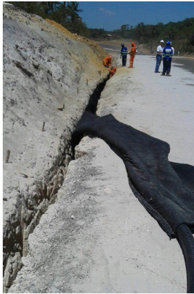
Figura 5.2 – Sistema drenante sendo colocado na trincheira (Fonte: Elaborada pelo autor).
