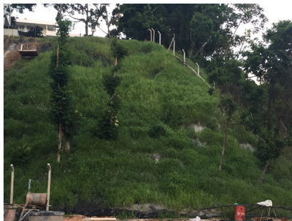
Figura 9 – Situação atual do talude
