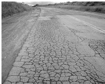
Figura 1- Superfície de pavimento asfáltico com trincamento excessivo. (Livro Drenagem Subsuperficial de Pavimentos. Ed. Oficina de Textos.)
