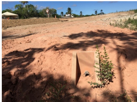
Figura 5.5 – Saída de água do sistema drenante (Fonte: Elaborada pelo autor).
