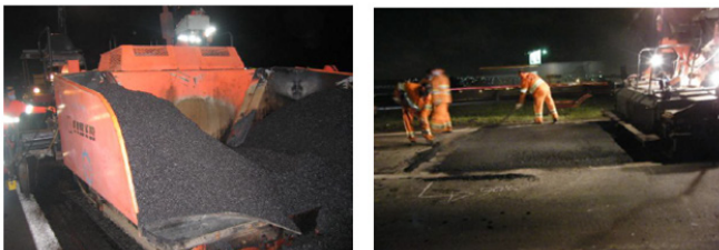
Figura 9 Fotos da aplicação da mistura morna
