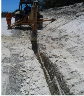
Figura 5.1 – Escavação das trincheiras (Fonte: Elaborada pelo autor).
