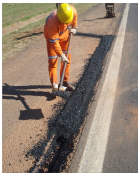
Figura 5.6 – Lançamento do material asfáltico no revestimento superficial. (MACCAFERRI).
