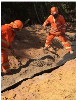
Figura 7.4 – Reaterro da trincheira escavada, obra BA -099. (Fonte: Elaborada pelo autor).
