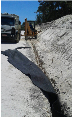
Figura 5.3 – Sistema drenante na margem da vala (Fonte: Elaborada pelo autor).
